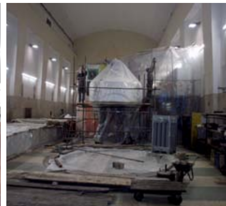
· Demontaža agregata A1
