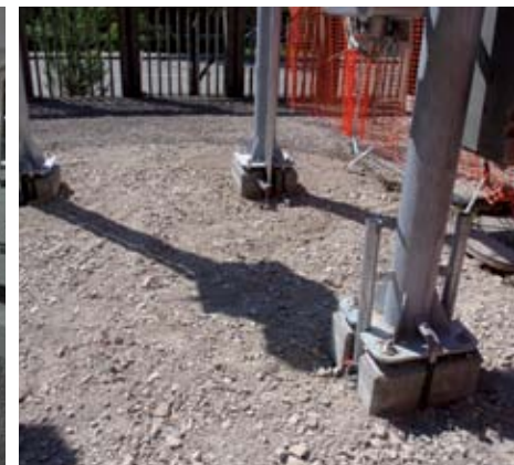
· Na zunanjem 110 kV stikališču se je obnovilo obstoječe temelje.
