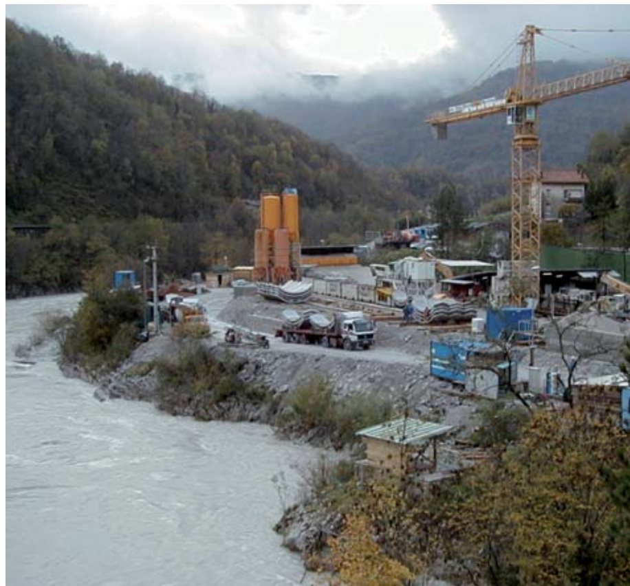
HE Dobljar II, gradbišče leta 1997
