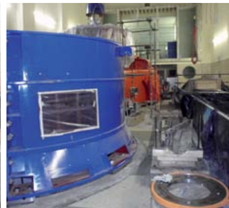
· Montaža statorja
