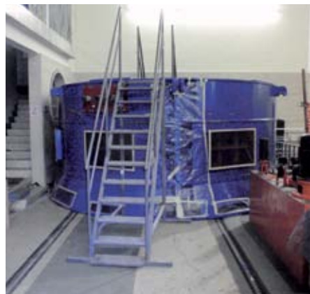
· Montaža statorskega ohišja
