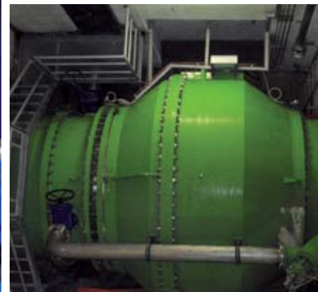
· Novi kroglasti zasun z obtačnim vodo (bypass)
