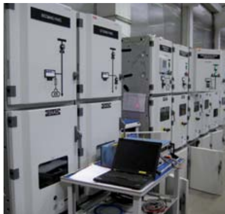
· Tovarniški prevzem srednjenapetastnih celic
