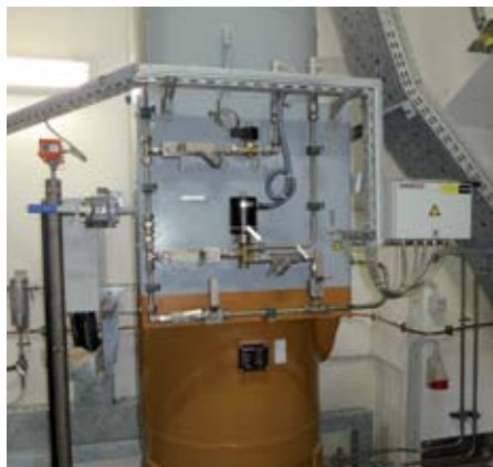
· Tlačna posoda olje zrak
