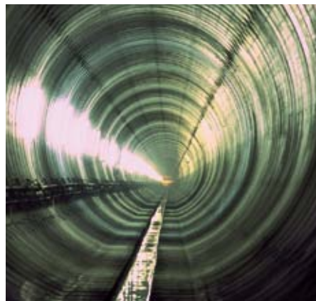
· Dovodni tunel HE Doblar II je tlačne izvedbe.
