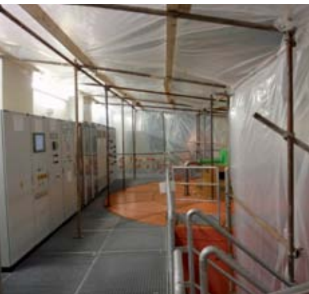
· Nove elektro omare so nameščene na dvignjenem kovinskem podestu ob agregatih
