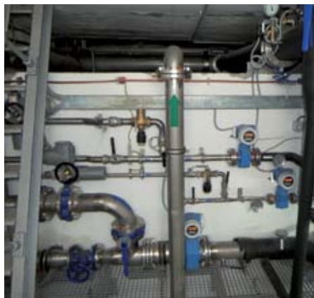
· Hladilni sistem generatorja
