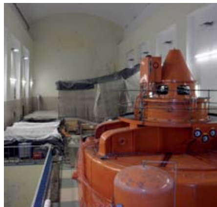
· Demontaža agregata A2
