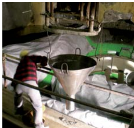
· Obbetoniranje spiralnega ohišja
