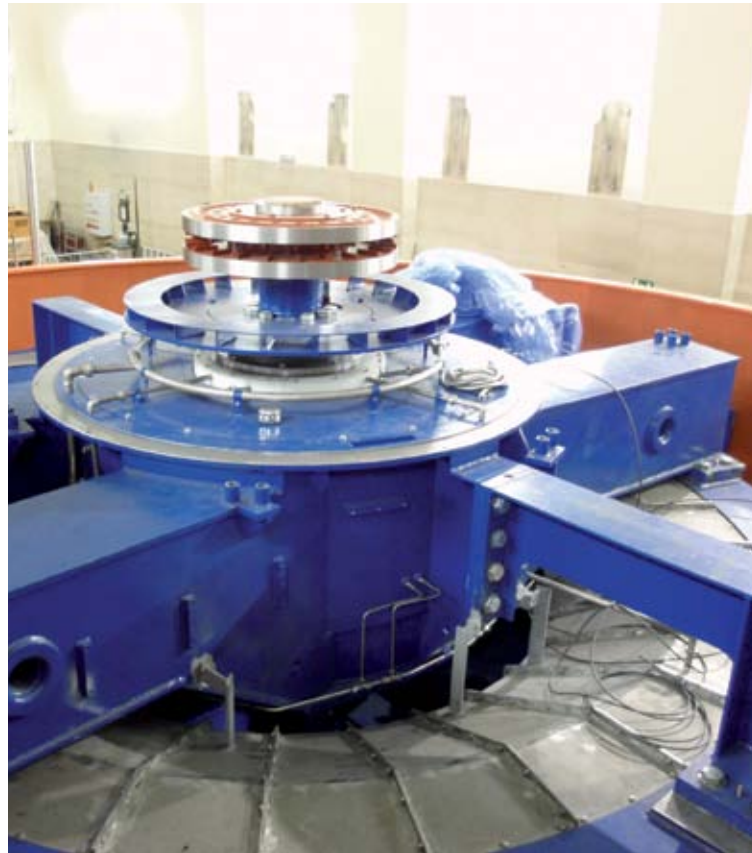
· Statorski križ z nosilnimi ležaji, ventilatorjem in drsnimi obroči
