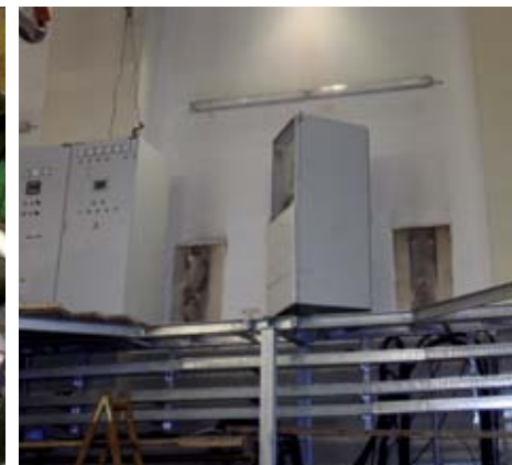
· Montaža dodatne vmesne etaže
