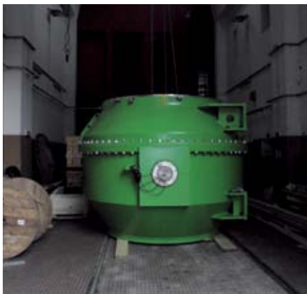
· Novi krogelni zasun na montažnem platuju
