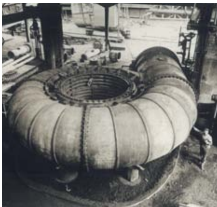
· Montaža prvega agregata HE Dobljar
