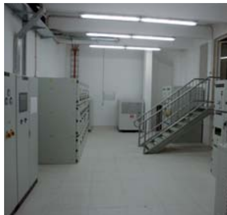
· V notranjem sredjenapetostnem stikališču so bili izvedeni manjši gradbeni posegi.
