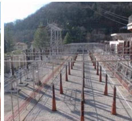
· Prenovljeno zunanje visokanapetastno stikališče sistema HE Dobljar
