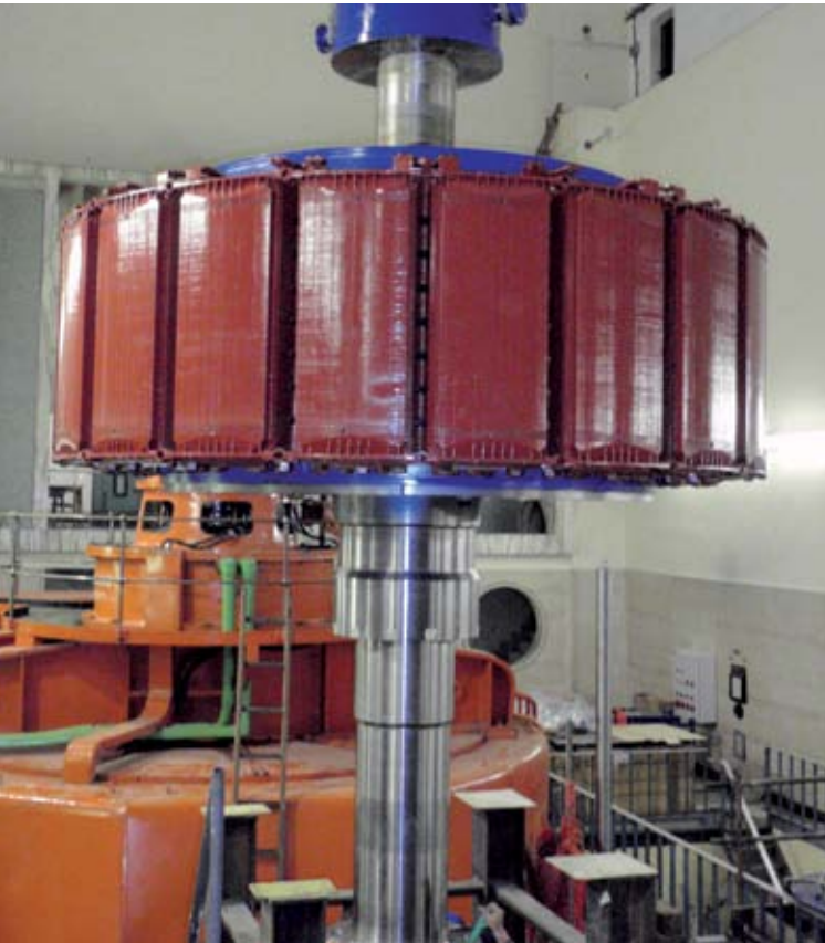
· Montaža rotorja
