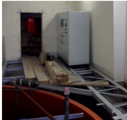
· Montaža elektro omar na kovinskem podestu
