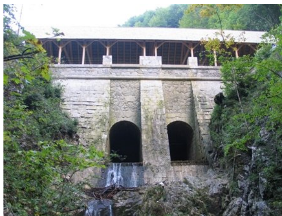
Slika 8: Kanomeljske klavže gorvodno
