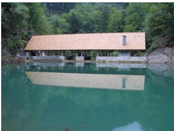
Slika 7: Kanomeljske klavže dolovodno
